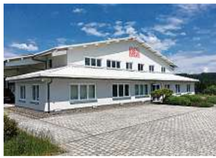
Ihr fünftes Werk in Deutschland nimmt die Haiterbacher Firma Durotherm GmbH in Unadingen in Betrieb. BILD: DUROTHERM GMBH
