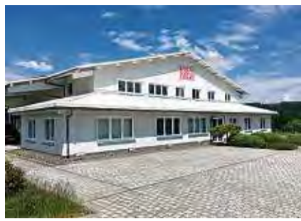
Ihr fünftes Werk in Deutschland nimmt die Haiterbacher Firma Durotherm GmbH in Unadingen in Betrieb. BILD: DUROTHERM GMBH
